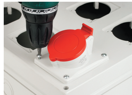
Монтаж розетки на 32 А
