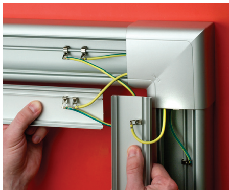
Количество монтируемых проводов заземления в плоском угле
