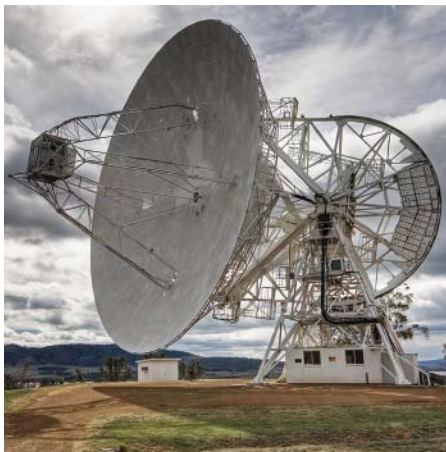
Системы управления и телекоммуникации
