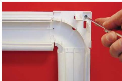
Вставьте в базу угла вторую часть кабель-канала. Закрепите их на стене
